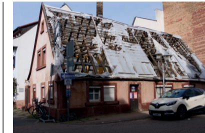
Fischerhaus vor Abriss Foto: Roswitha Claus
